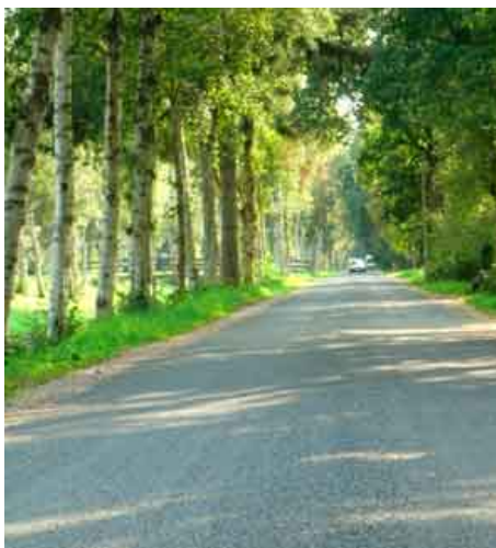
Die Dorfstraße in Kuhstedtermoor wurde komplett saniert.
